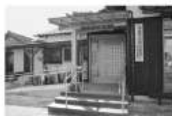
△公民館入口の段差を低くしスロープを付けました。(助丸)
